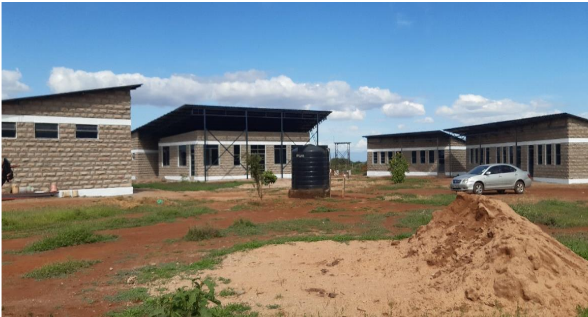
Links het slaapgedeelte en het toegangsbouw. Rechts het 'skills' centrum en het klaslokaal.
